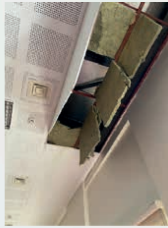
Şekil 3.50. Asma tavan ve bölme duvar hasarları
