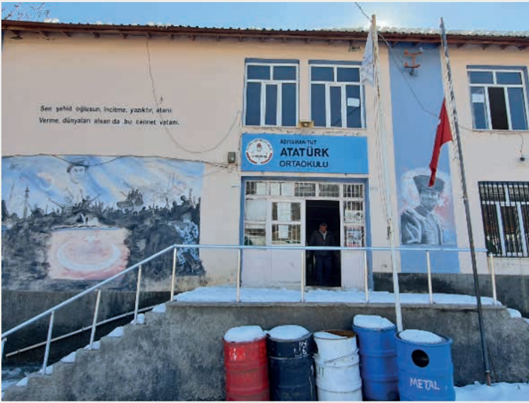
Şekil 3.29. Tut ilçesinde iki katlı yığma okul binası
