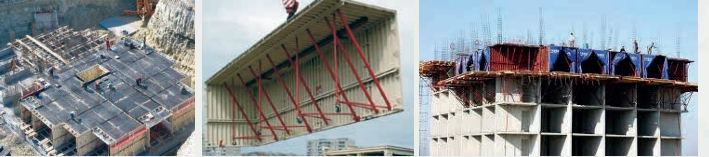
Şekil 4.3. Tünel kalıp sistem ile bina inşaatı
