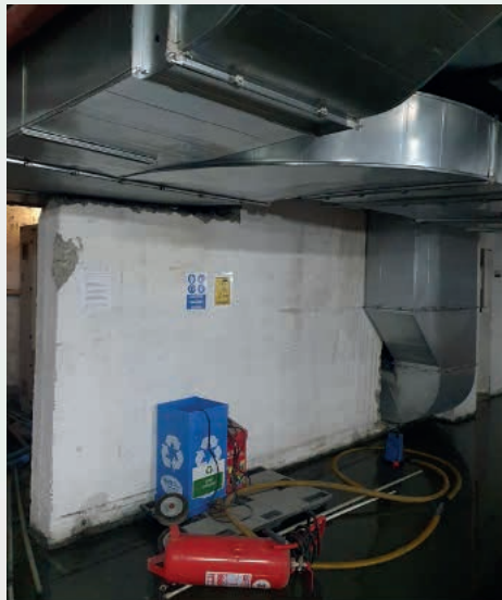
Şekil 3.47. Adıyaman Özel Gözde Tıp Merkezi kesilen betonarme perde duvar
