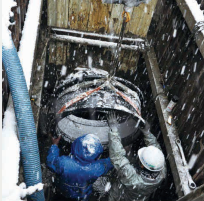
Şekil 5.2.3. Büyük Doğu Japonya Depremi sonrasında 800 mm çaplı bir su dağıtım borusunun tamiri (Wakamatsu ve diğ., 2016).
