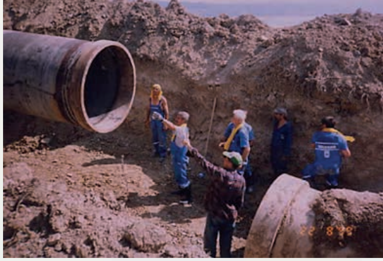
Şekil 5.2.1. Deprem sonrası hasar gören asbestli çimento boru hattında onarım ve yenileme çalışmaları (Ansal ve diğ., 2008)
