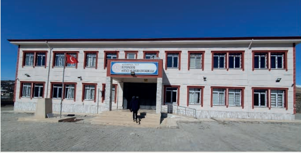
Şekil 3.67. Boyundere Hatice Yıldırım Ortaokul binası
